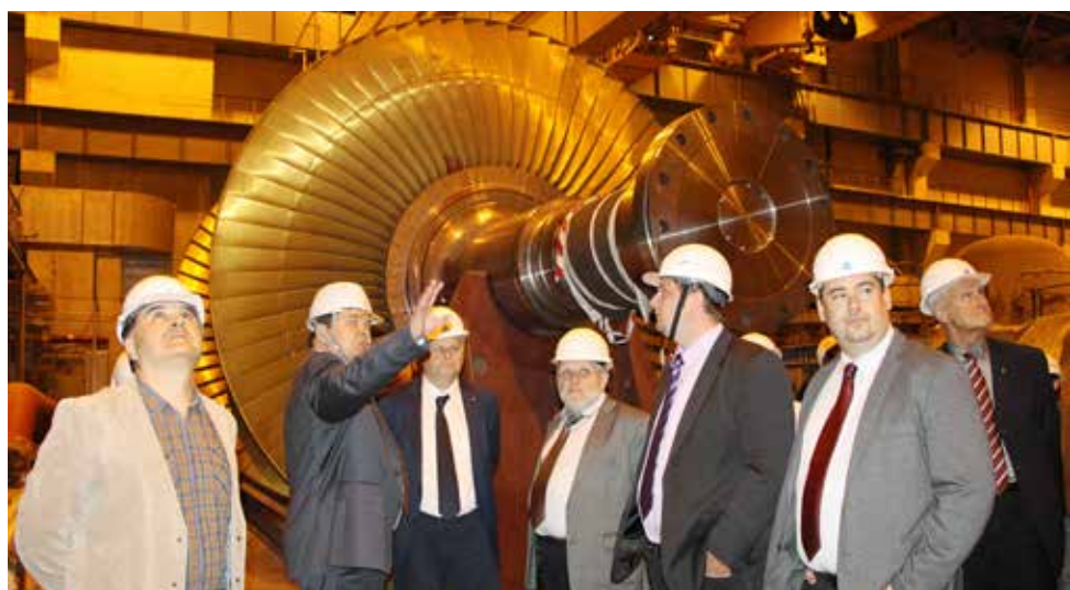
В турбинном зале Ленинградской АЭС-2
