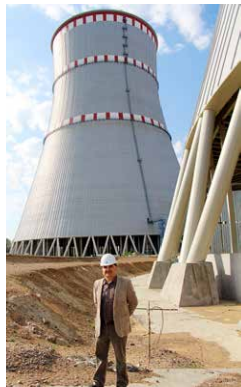
Градири ЛАЭС-2 — шедевры российских инженеров и строителей
