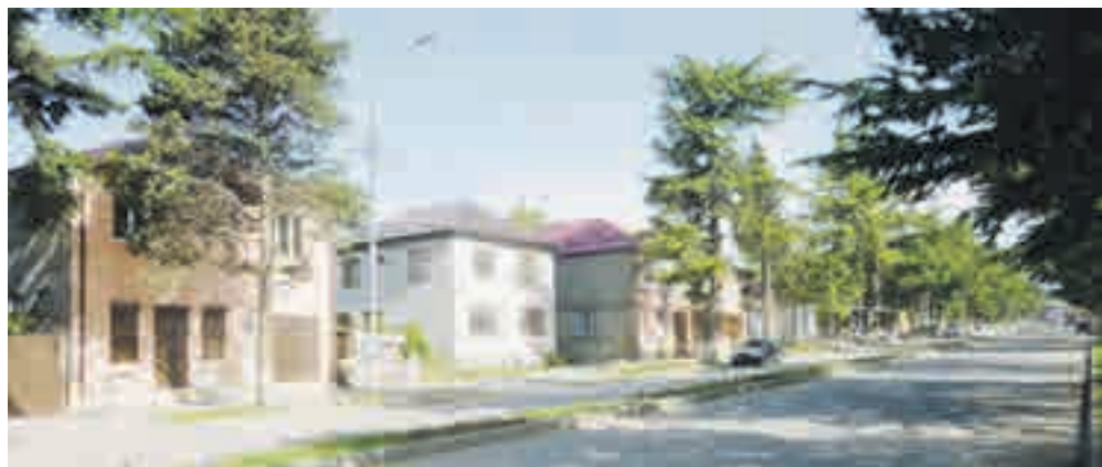
Восстановленные дома Цхинвала
