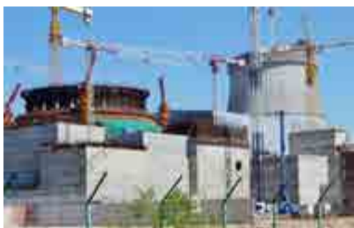
ЛАЭС-2 строится по новейшим технологиям
