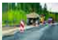
Дороги области стр. 5
